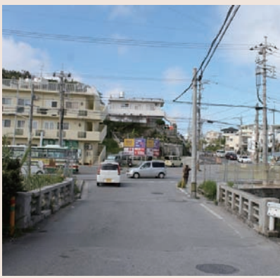
もともとは石造りのアーチ橋だったが、沖縄戦で破壊され、現在はコンクリート橋に。
