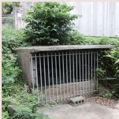
マンションの裏にひっそりと残るカブイガー。現在は安全性を考慮して柵で囲まれている
